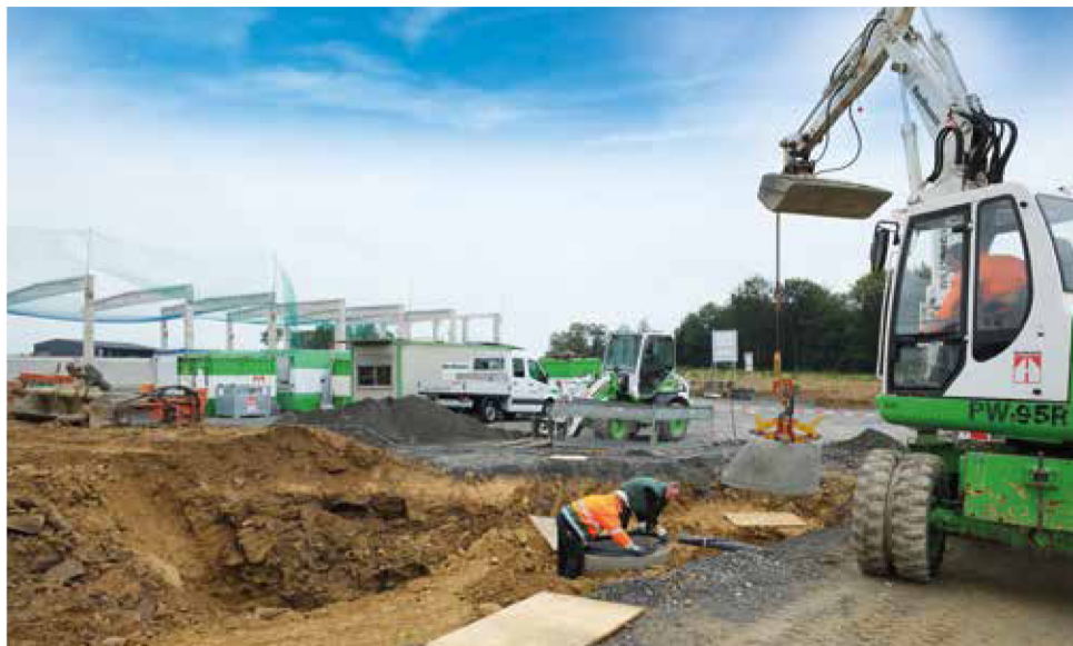
▲ Beim Setzen eines Schacht-Konusses (v. l.) Joachim Sturm, Stefan Trapp und Carlo Spinolla
