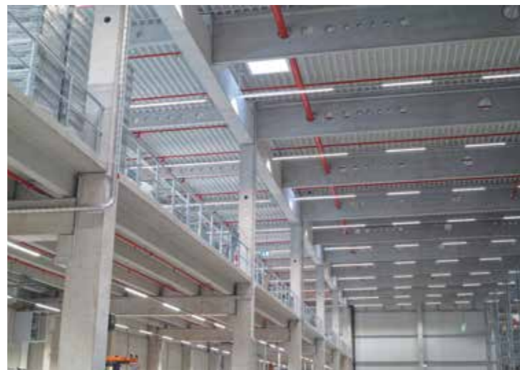
▲ Alle Stahlbeton-Fertigteile kommen aus eigener Produktion.
