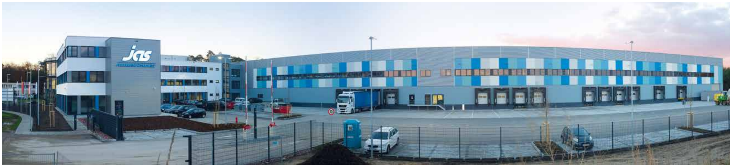
▲ Verwaltungsbereich mit angrenzender Logistikhalle
